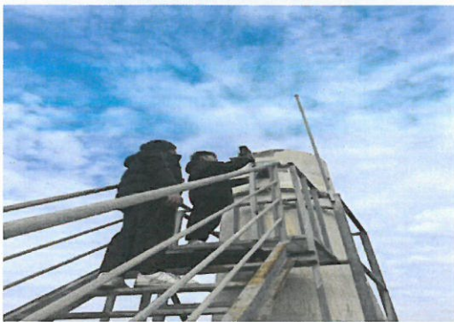
碱性废气排气筒 2#出口
