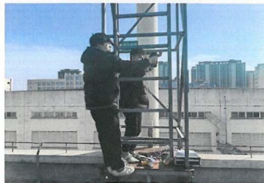
废水处理站废气排气筒出口
