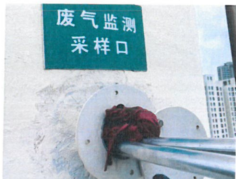
酸性废气排气筒 1#出口
